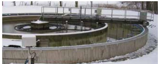
*Ob in Stade (links) oder in Soisdorf (rechts): Die mit Edelstahl verkleidete, beheizbare Beckenkronen sieht nicht nur gut aus – die patentierte Bauweise hält extrem lange und reduziert den Räumerverschleiß erheblich.*
