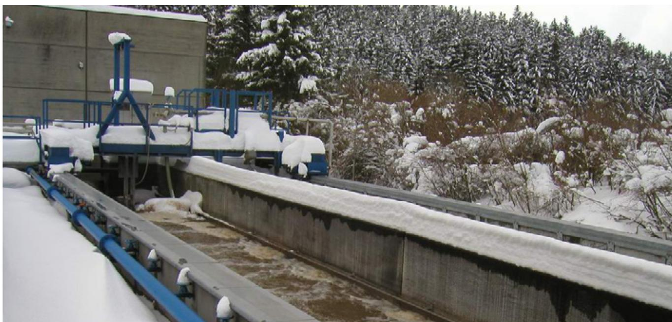
Klar, dass eine beheizbare Räumfahrbahn den Winterbetrieb erheblich erleichtert. Dass hierbei auf externe Energiequellen verzichtet werden kann und damit die Betriebskosten einer solchen Heizanlage beinahe gegen null tendieren, ist dagegen neu. Die beiden Abbildungen zeigen eine solche Anlage; sie wurde im vergangenen Winter bereits umfangreichen Tests unterzogen und hat sich hervorragend bewährt. Innovative Technik aus dem Hause Krumme! Wir informieren Sie gerne!
