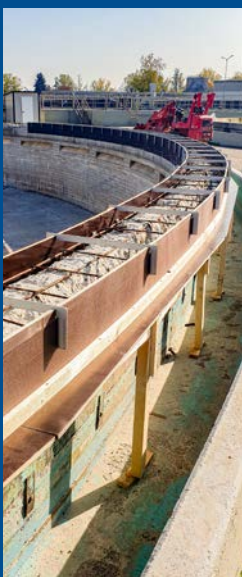
Reggio Emilia / aufwendige Betonsanierung mit Räumlerlaufbahn
