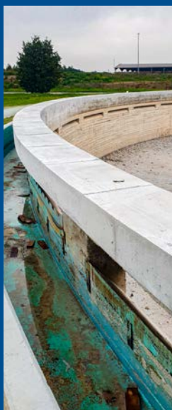
Reggio Emilia / aufwendige Betonsanierung mit Räumlerlaufbahn
