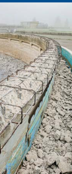
Reggio Emilia / aufwendige Betonsanierung mit Räumlerlaufbahn
