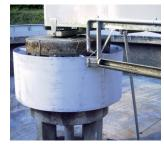
... Ablaufrinnenaus- oder Königsstuhlverkleidungen z. B. aus hochwertigem Edelstahl in verschiedenen Werkstoffgüten, überwiegend in 1.4571 kaltgewalztem V4A-Edelstahl
