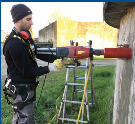
op statief geplaatste kernboormachine in de natte boormethode
