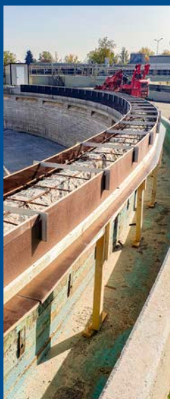
Reggio Emilia / complexe betonsanering met omloopranden voor ruimers
