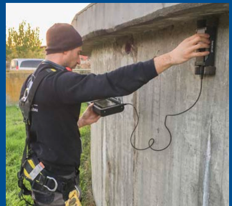
Wapeningscan om de wapeningslagen en de betondekking te berekenen
