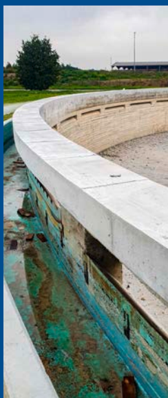
Reggio Emilia / complexe betonsanering met omloopranden voor ruimers
