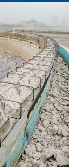
Reggio Emilia / complexe betonsanering met omloopranden voor ruimers
