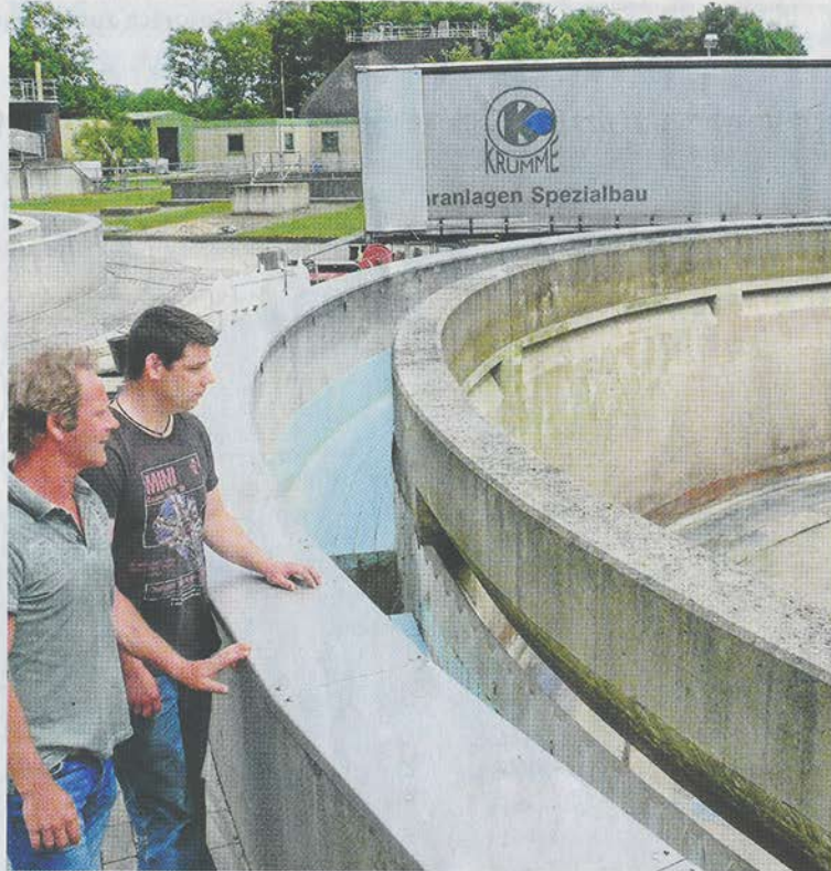
Eine ganz runde Sache ist die neue Edelstahlabdeckung der Nachklärbecken, die Thomas Rabel (l.) von der bauausführenden Firma und Dirk Bröker, Ver- und Entsorger im Metelener Abwasserwerk, unter die Lupe nehmen. Ingenieur Jonas Sabe (Foto r.) zeigt die eingefrästen Nuten für die Heizleitungen. MZ-FOTOS HUGO SIVE HUWE
